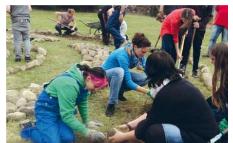
Fleißige Helfer beim Bau des Kräuterlabyrinths.
